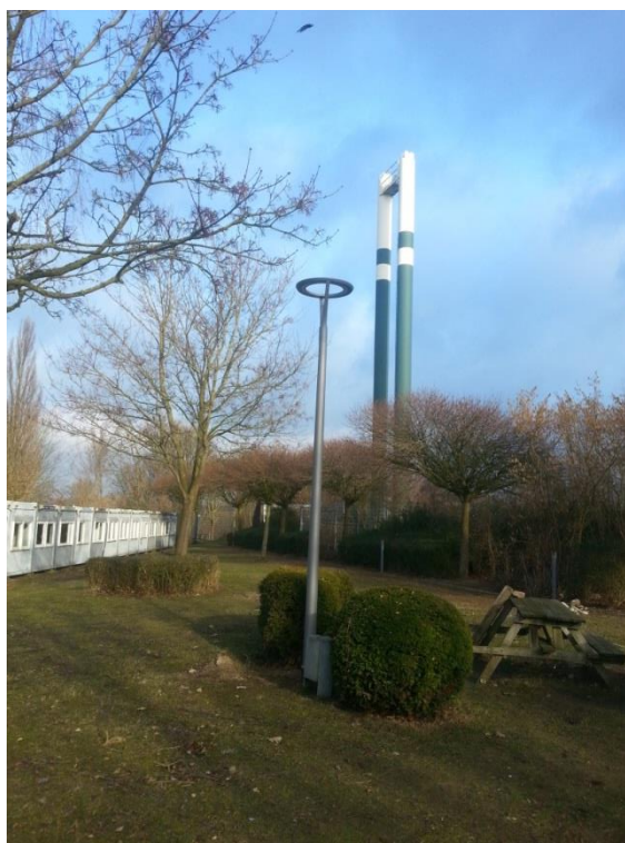
LED-Außenbeleuchtung BS Bad Oldesloe, Fotos Kreis Stormarn, Paul Gärtner
