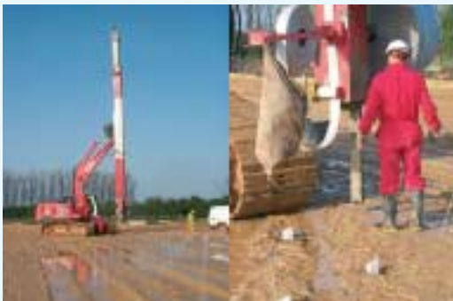
Gründungsarbeiten für die Autobahn im Alten Land.
