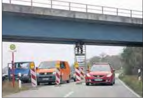
Heute soll der Autoverkehr über die B 75 bei Wesenberg wieder normal laufen. Foto: MC
