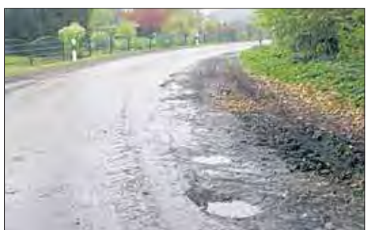
Matsch und Schlaglöcher: Die Straßen in Seefeld sind in schlechtem Zustand, der Grund dafür könnten die Maislaster sein. Foto: J. SEELIGER
