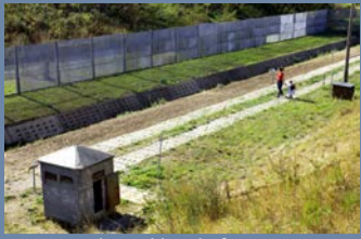
Foto: Grenzhus Schlagsdorf
