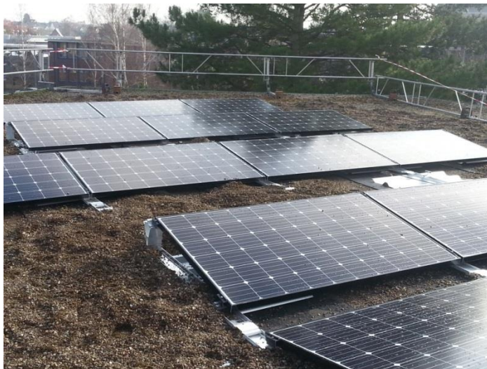
PV-Anlage KT-Saal im Aufbau, Foto Kreis Stormarn
