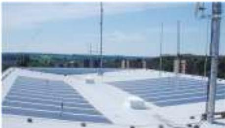
**PV-Fassaden-Anlage auf Gebäudedämmung
