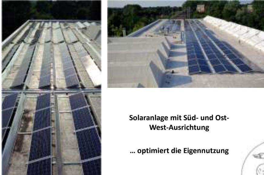
Solaranlage mit Süd- und Ost-West-Ausrichtung
